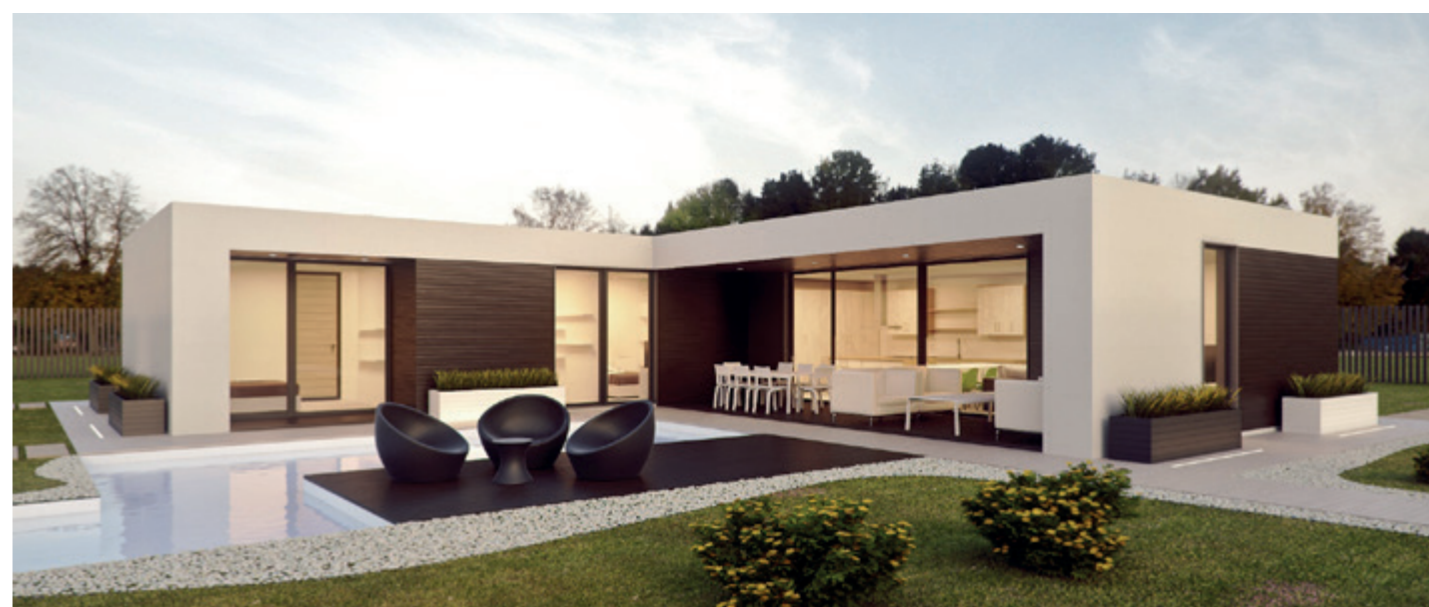
Výhody hypoték v porovnání se stavebním spořením jsou nižší úrokové sazby, zpravidla nulové poplatky za vedení úvěrového účtu, možnost volby typu úrokové sazby a doby fixace úrokové sazby. Foto redakce
